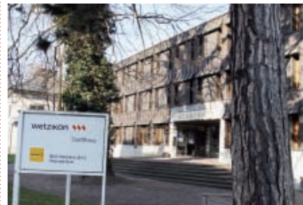
Ausbau und Sanierung drängen sich auf.
